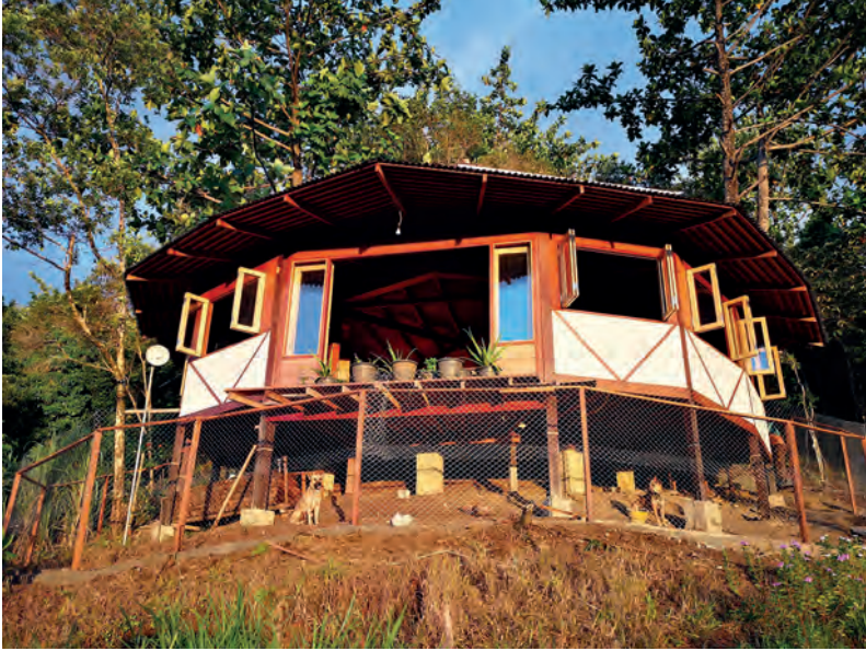
Fertigstellung des Hauses
